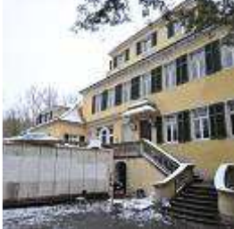
Umbau im Haus Eulenbroich
